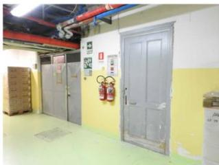
L103 Serramento esistente di futura sostituzione con porta inferna in lamiera con caratteristica REI 120 (porta a destra) e portone esistente oggetto di rimozione e successiva chiusura del varco con compartimentazione REI 120
